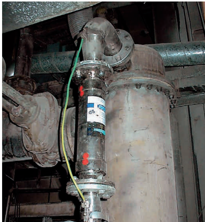
ION-SCALE BUSTER: protegge il condensatore ausiliario
