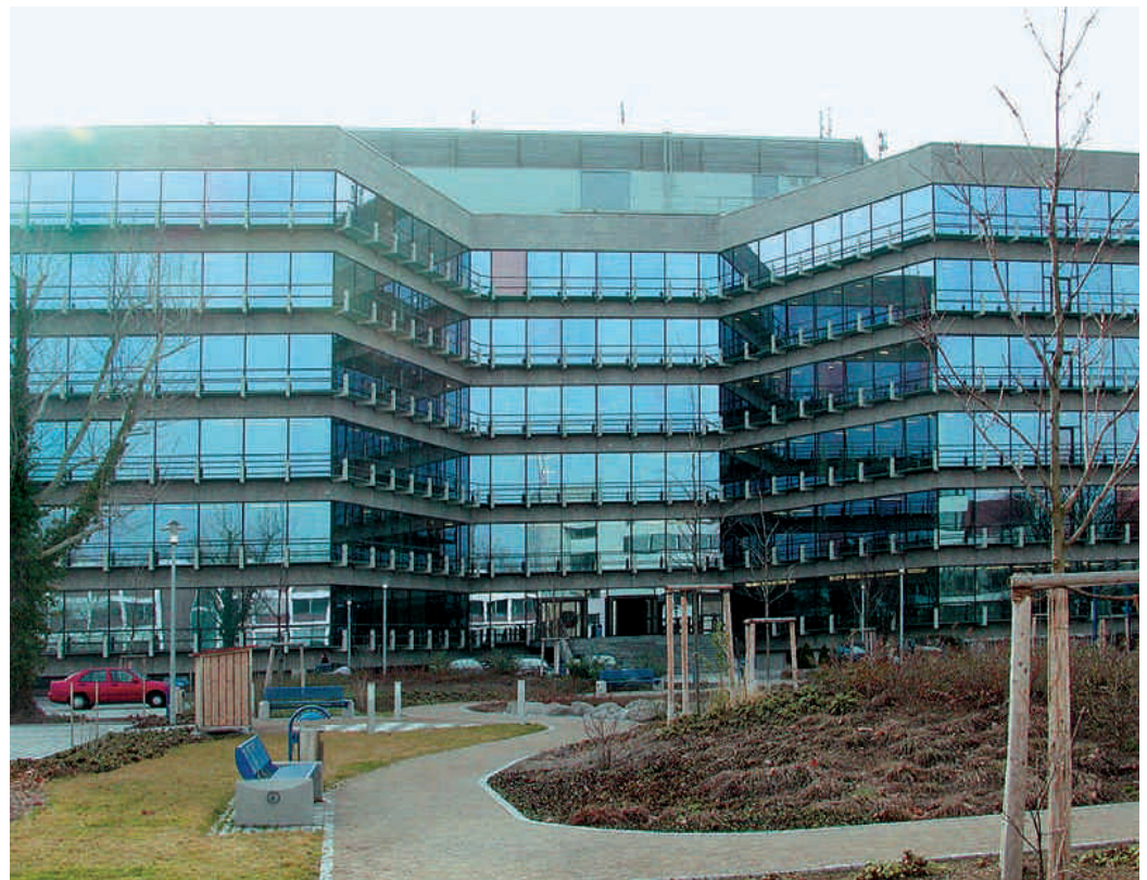
"WABENBAU" PRIVO DI CALCIO L'edificio amministrativo della ABB Gebäudetechnik di Mannheim.
